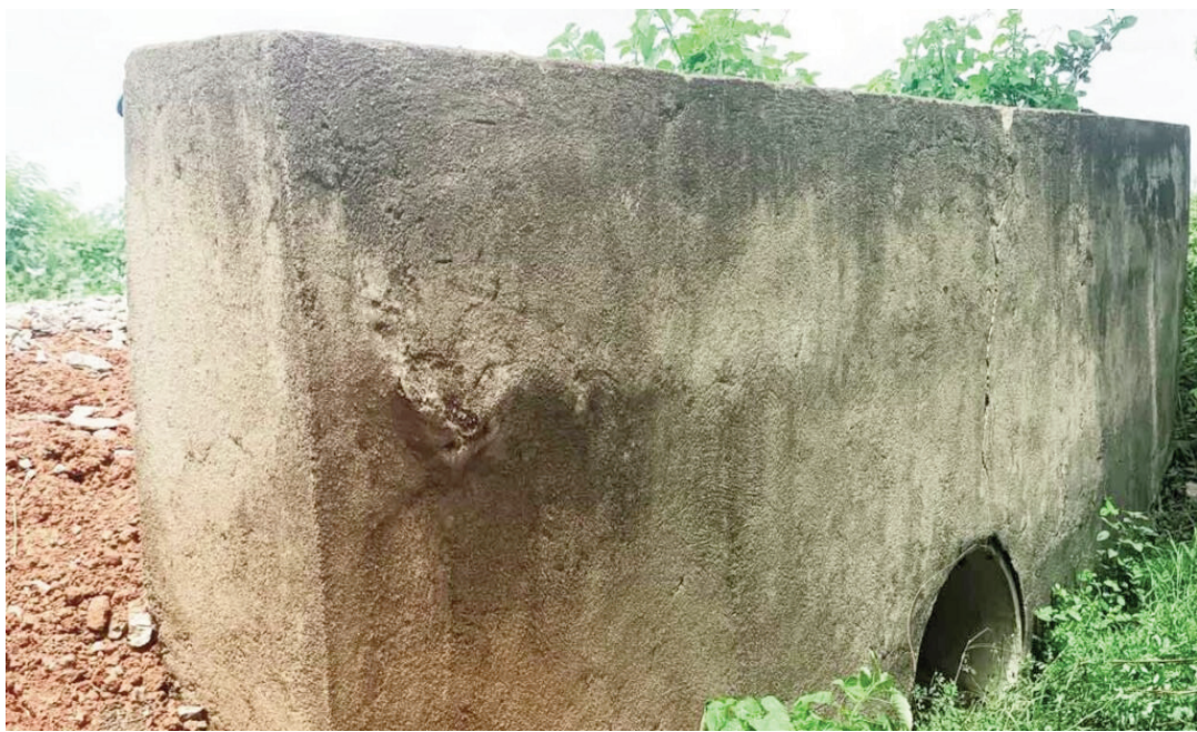
రోడ్డు మధ్యలో శిథిలమైన కాలవ్ట్ తొలగించి సూతన కల్వర్ట్
