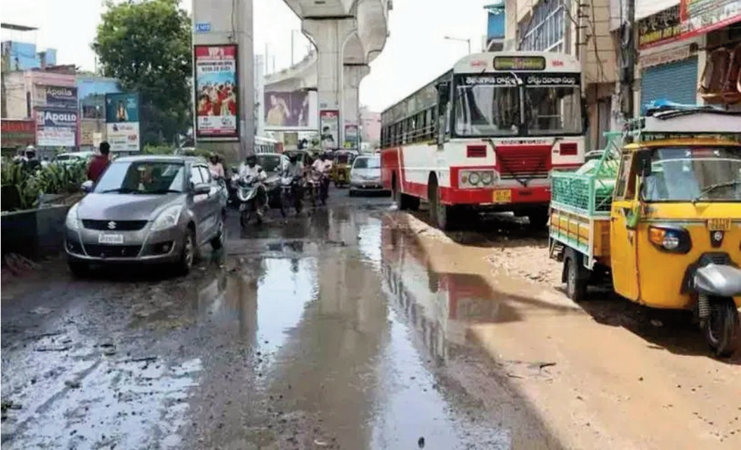
మార్గంలో డ్రైనేజీ మురుగునీరు వారం రోజులుగా పొంగిపొర్లుతుండటంతో వాహనదారులు ఇబ్బందులు పడుతున్నారు. మురుగు నీరంతా మలక్‌పేట అండర్ రైల్వే బ్రిడ్జి వరకు వెళ్లడంతో వాహనదారులు ఇబ్బందులుపడుతున్నారు. మలక్‌పేట రైల్వే బ్రిడ్జి వద్ద మురుగునీరు నిలిచి పోవడంతో గంటల తరబడి వాహనదారులు నరకయాతన అనుభవిస్తున్నారు. ఇదిలా ఉంటే మలక్‌పేట- నల్గొండ క్రాస్ రోడ్లలో మురుగునీరు
